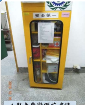
△緊急應變櫃前建議張貼一覽表，便於定期實施自動檢查及緊急時方便取用
