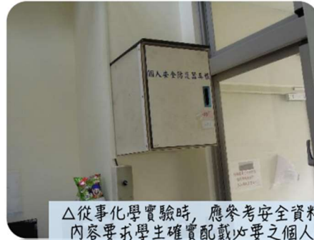
△氣櫃屬規定之局部排氣裝置應定期實施自動檢查，使其有效運轉
