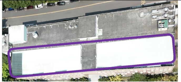
機械工程館 (155.1 kWp)
